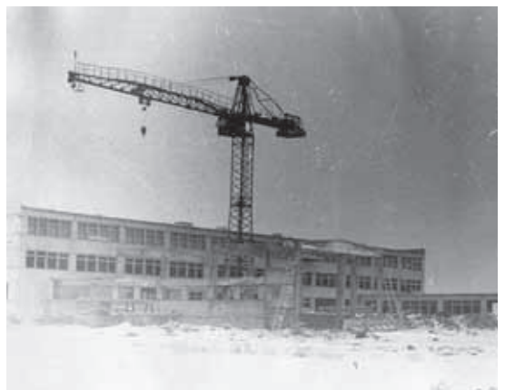
Строительство новой школы.
