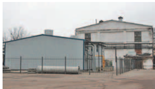
Новая котельная завода «Калибр».
