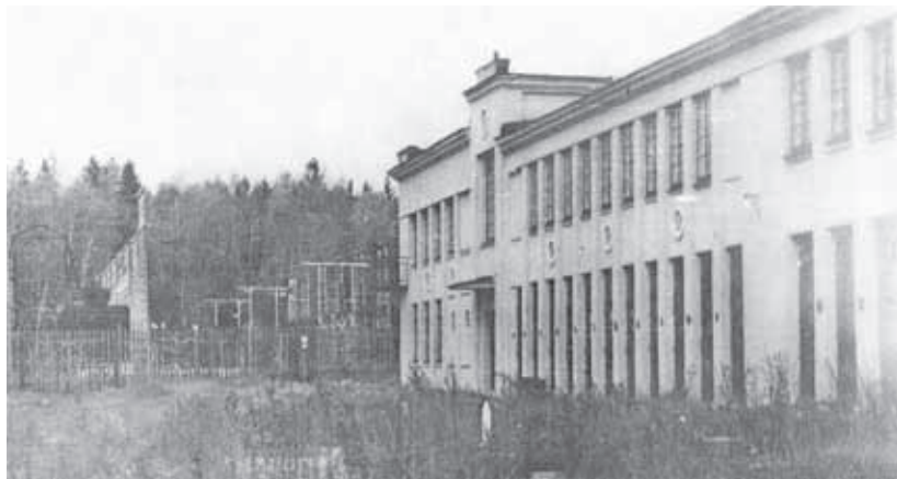
Подстанция № 228 в годы войны.
