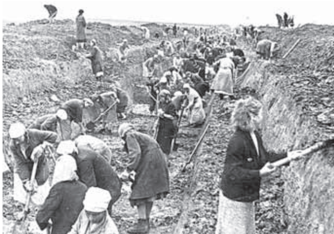
Дмитровчане на строительстве оборонительных сооружений, август 1941 г.
